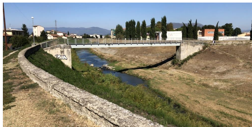
Fig. 2.2.xxxii –Ponte pedonale tra via Ombrone e via C. Battisti.
