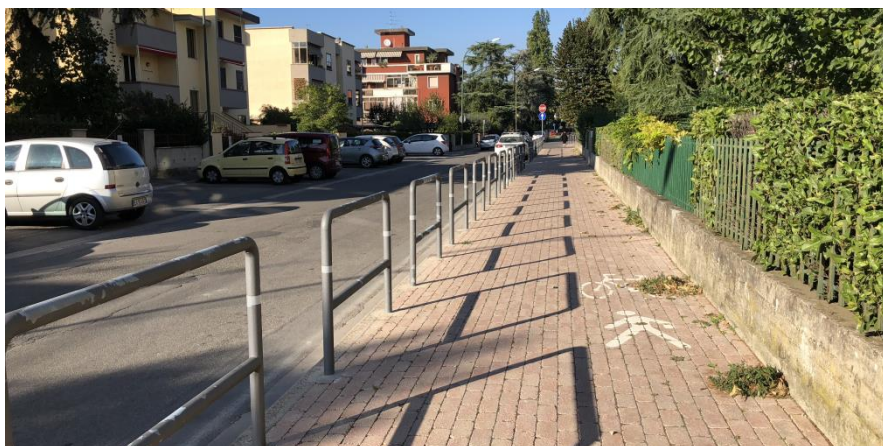
Fig. 2.2.xxxv –Pista ciclopedonale su via Michelangelo Buonarroti.
