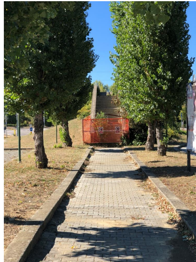
Fig. 2.2.xli –Ponte sopra la via Parco Marinella chiuso al transito Rilievo diretto META 2018
