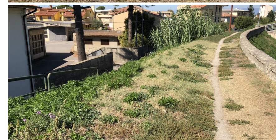
Fig. 2.2.xxxix –Foto dei passaggi per la manutenzione degli argini
